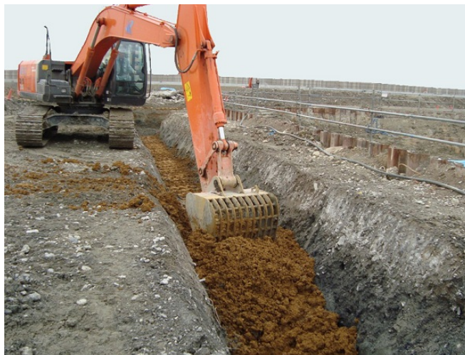
透過壁の施工状況写真
