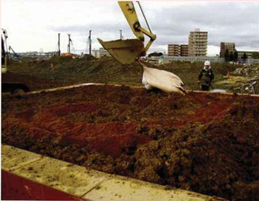
バックホーでHMC-Zと砂質土を混合する
