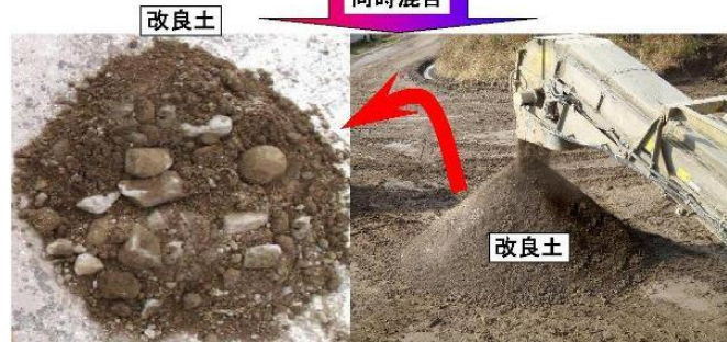
自走式3種同時混合土質改良実験状況
