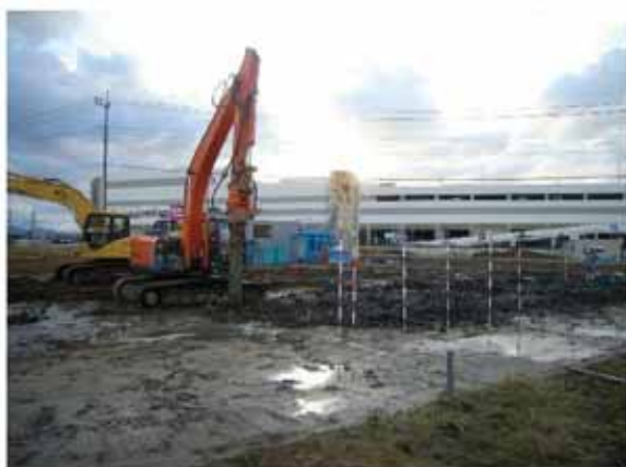
施工状況 【攪拌状況】
