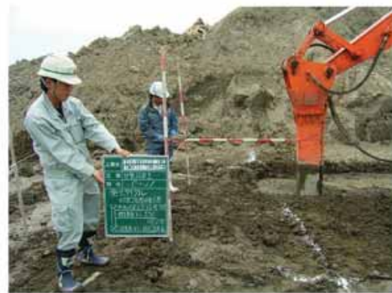
施工状況 【深度確認】
