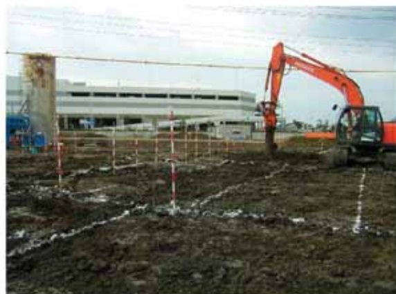
施工状況 【攪拌状況】
