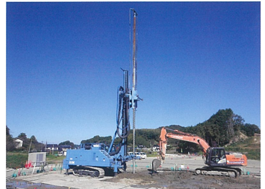
液体施工:中層式混合処理機
