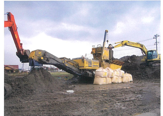
粉体施工:自走式土質改良機
