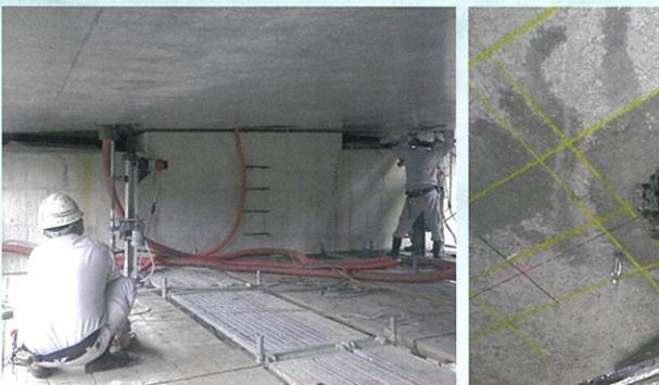
PC橋梁耐震化工事のアンカー削孔に用いたものです。φ30mm～φ100mmまで対応。
